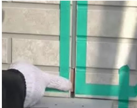
Выравнивание герметика шпателем
