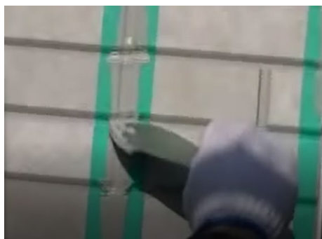
Выравнивание герметика шпателем
