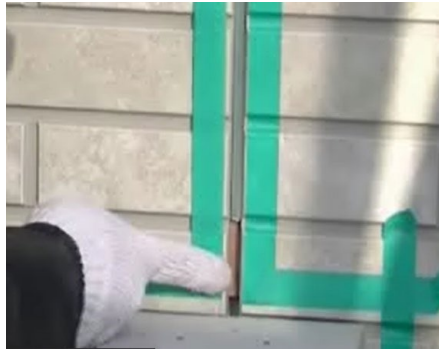
Выравнивание герметика шпателем
