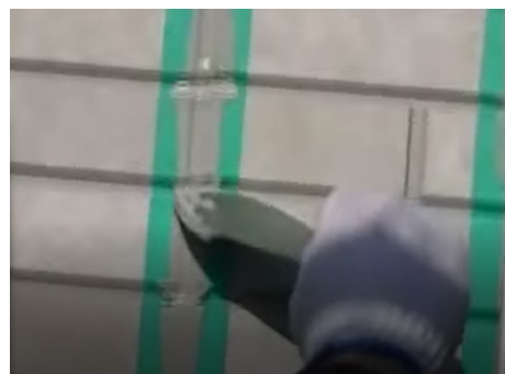
Выравнивание герметика шпателем
